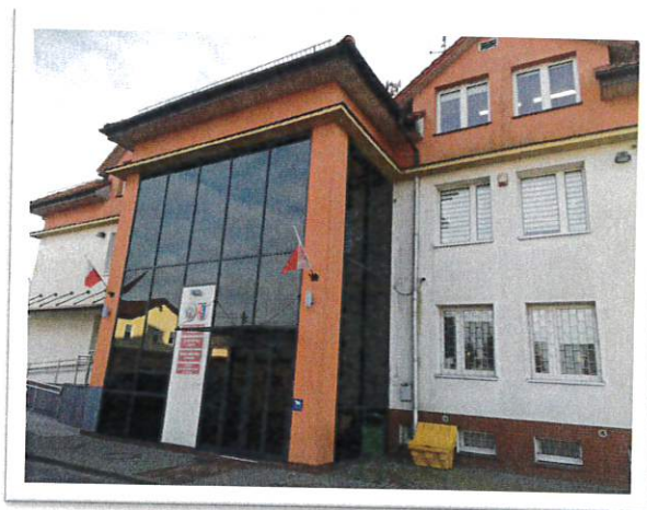
Budynek Urzędu Miejskiego
